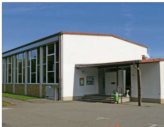
Größere Bauarbeiten vor allem im Eingangsbereich stehen bei der Turnhalle in Endingen an.
